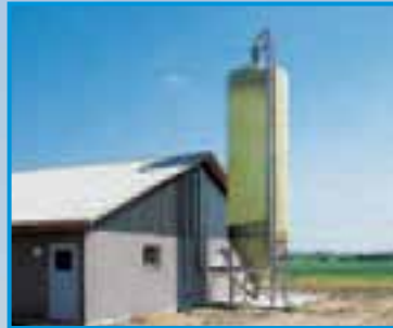
Silofärg: Klar topcoat – fodret kan ses genom siloväggen!
